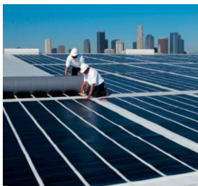
Instalación de membrana fotovoltaica en cuberta.
