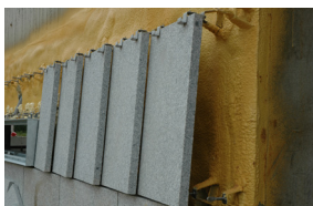
Construción de fachada ventilada pétreo.
