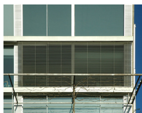
Lamas exteriores como sistema de protección solar nun edificio con grandes ventás orientadas ao oeste.
