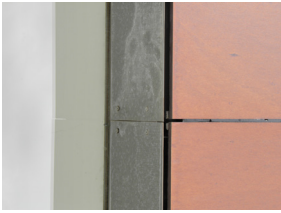
Detalle de fachada ventilada con pezas cerámicas.
