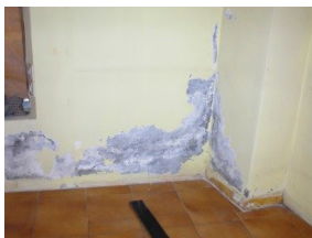
Aspecto do interior dun muro con lesións de humidade por ascenso capilar.
