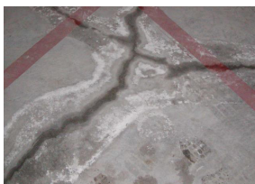
Eflorescencias por humidade capilar a través dunha greta en todo o espesor dunha soleira.
