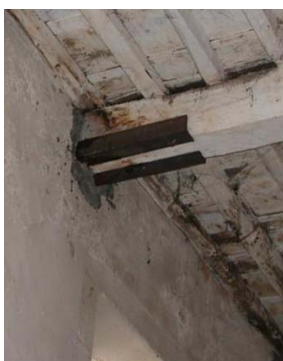
Reparación da cabeza dunha viga ou vigueta con angulares de aceiro.
