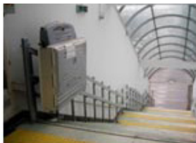
Edificio de uso público no que se crea unha rampla interior para persoas discapacitadas.
