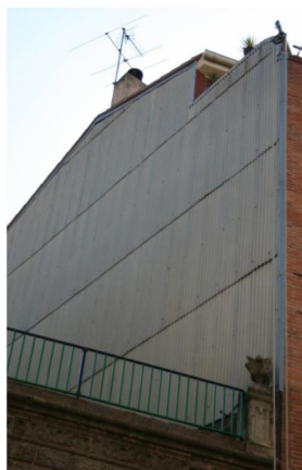
Medianeira protexida con revestimento de placas onduladas de fibrocemento.
