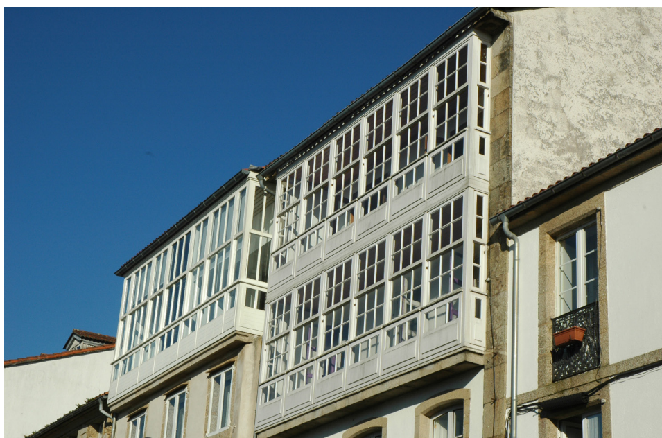
Utilización de galerías como elementos de captación solar. Santiago de Compostela
