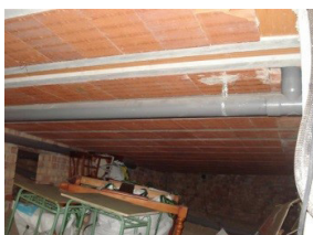
Forxado unidireccional como chan elevado, con acceso para mantemento de instalacións suspendidas.
