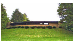
Casa Jacobs II, F. Lloyd Wright. Aproveitamento da alta inercia térmica dos muros de pedra semienterrados como acumuladores da enerxía captada a través da fachada sur.
