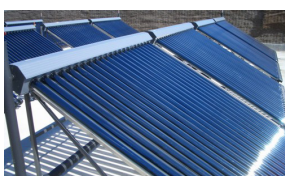
Captador solar de tubos de baleiro.
