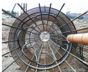
Colocación de tubos para captación en pozo.
