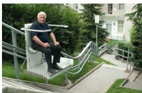
Modelo de salvaescaleiras para a accesibilidade nun forte desnivel dunha urbanización.
