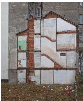
Medianeira sen revestimento tras a demolición do edificio lindeiro.
